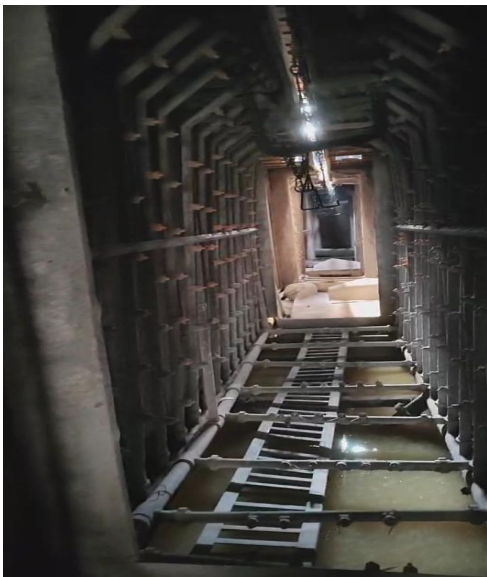
图 4.1-4 表面清洗房“屋中屋”全封闭图
