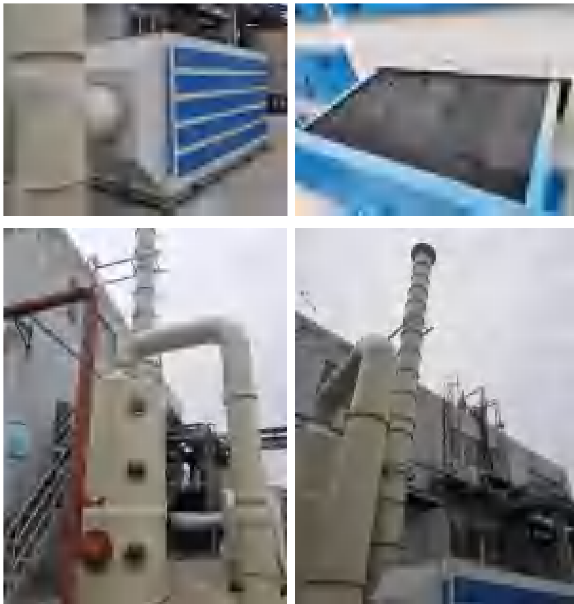
图 4.1-1 项目废气收集及处理设施现场照片
