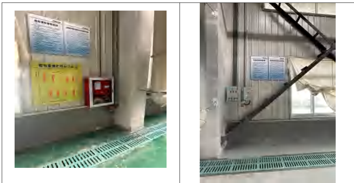
图 3.8-2 项目 9#、10#危废库照片
