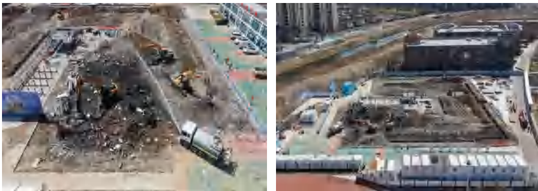
图2 原锅炉房拆除后照片
