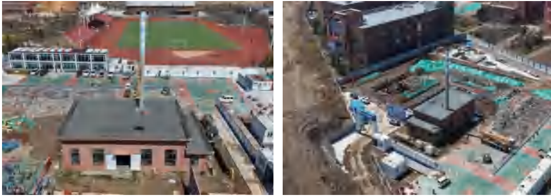
图1 原锅炉房拆除前照片
