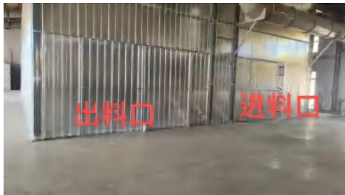
封闭进料口及出料口
