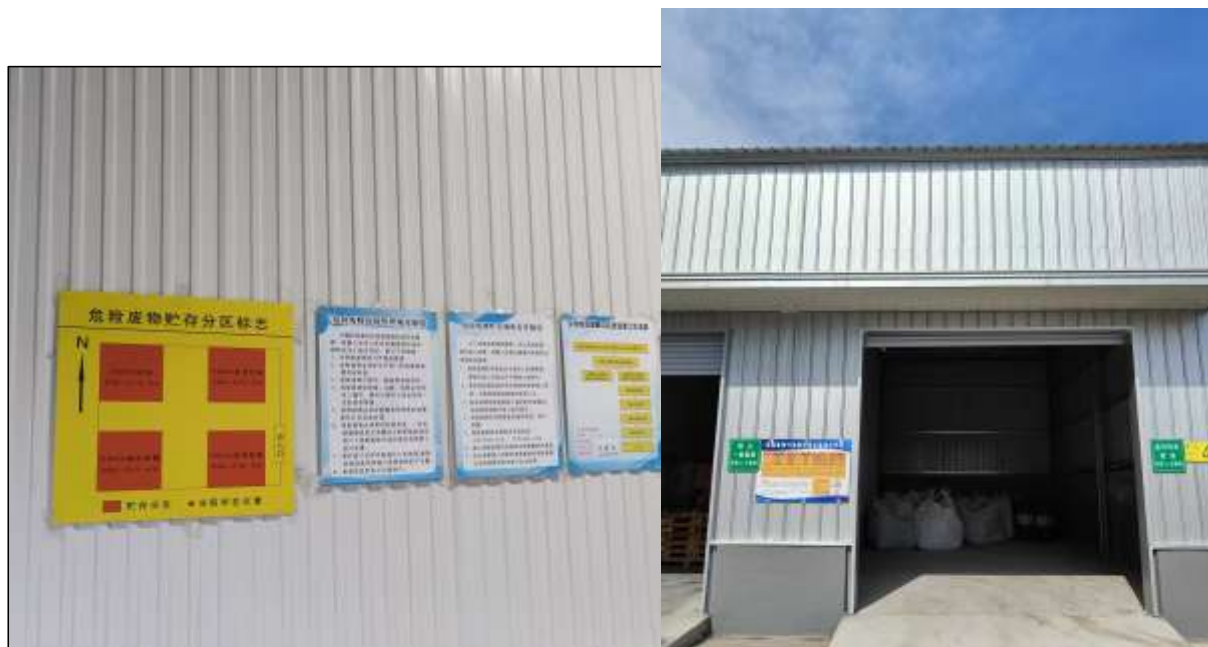
图4-3 项目危废暂存间
