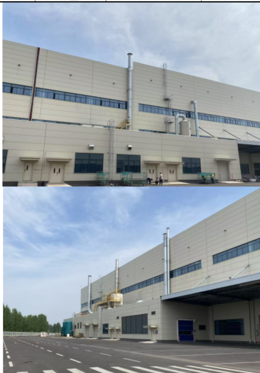
图 4-3 项目废气处理措施图
