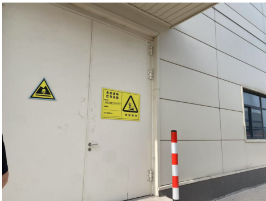
图 4-4 项目危险废物暂存间图片
