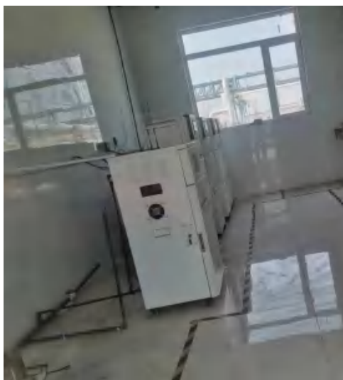
图 4-6 废水在线监测设施照片
