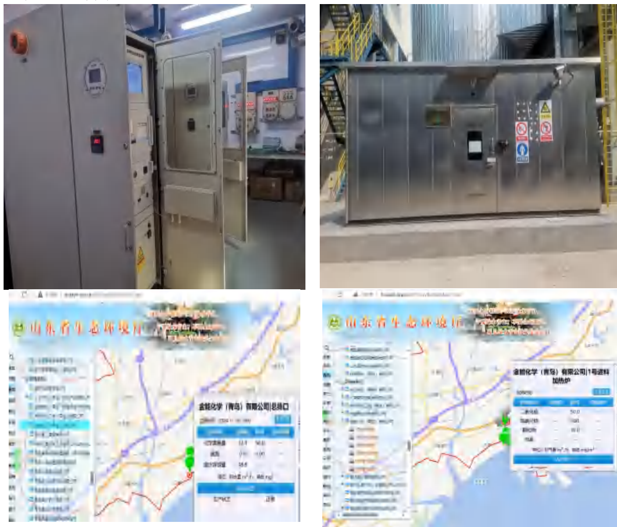
图 4-4 废气在线监测设施及联网照片
