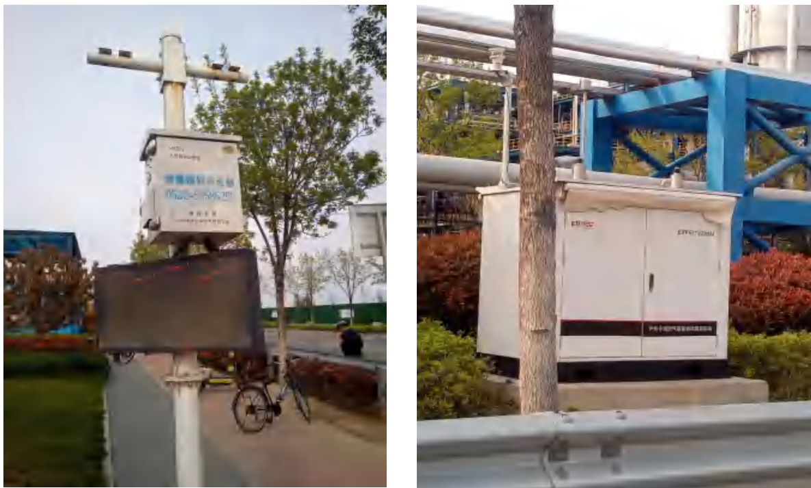
图 4-5 厂界无组织废气在线监测设施照片
