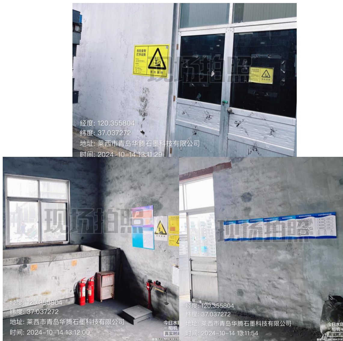
图 4-3 项目危废暂存间
