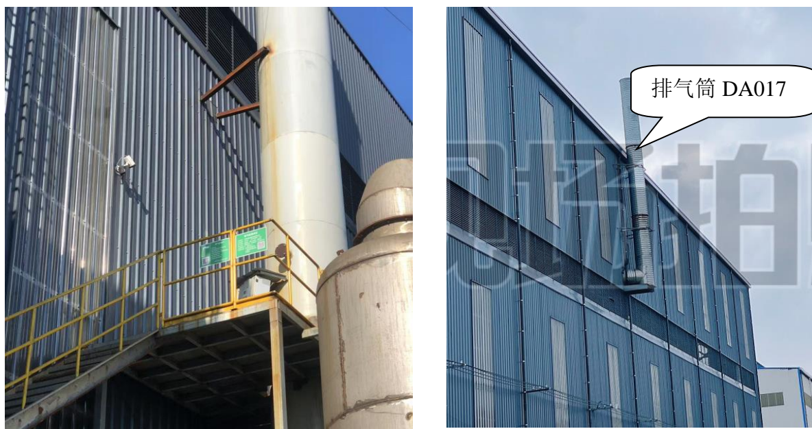
图 4-2 废气环保设施照片
