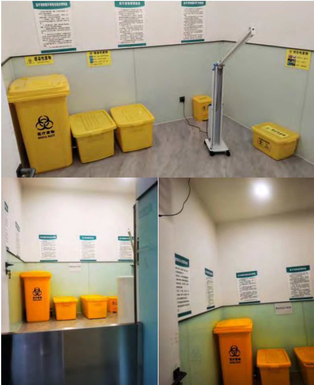
图 4.1-3 医疗废物暂存间照片
